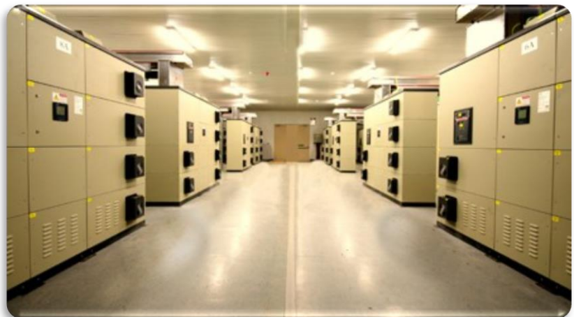
Monitoramento de tensão de 161kV em uma faixa de +/-3%, Austrália
